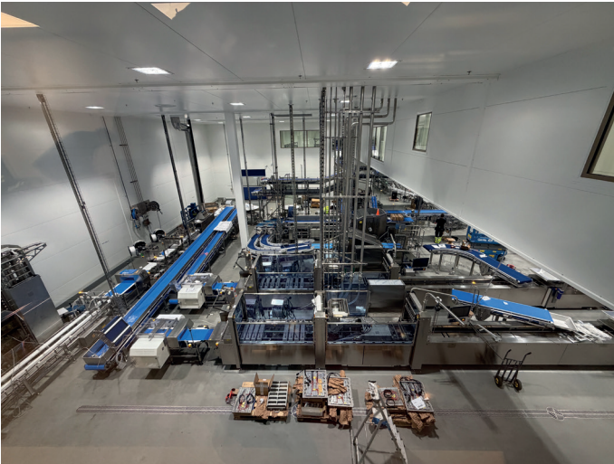
Hele bygget er satt opp rundt fileteringsanlegget.
